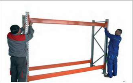
11 Muut vaakapalkit asennetaan hyllysuunnitelman mukaisesti.
