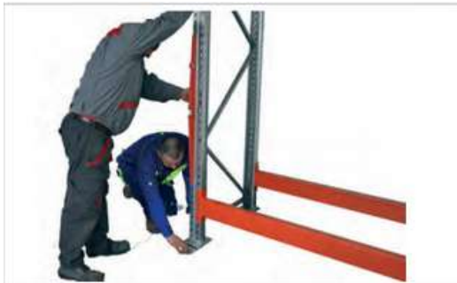
14 Pystysuoruden mittaamisen jälkeen suoritetaan tarvittaessa säätö.
