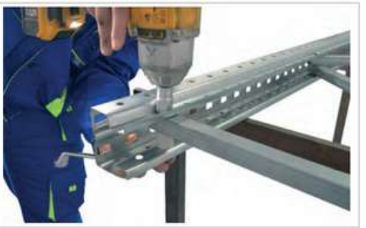
6 Aloita tuentojen asennus vaakatuen kiinnityksellä.
