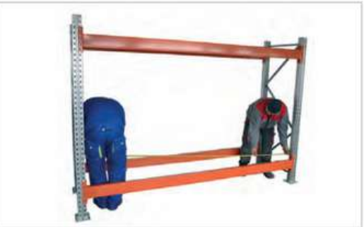
12 Hyllyvälikön ristimitta tarkistetaan. Maksimi toleranssi +/- 3 mm.
