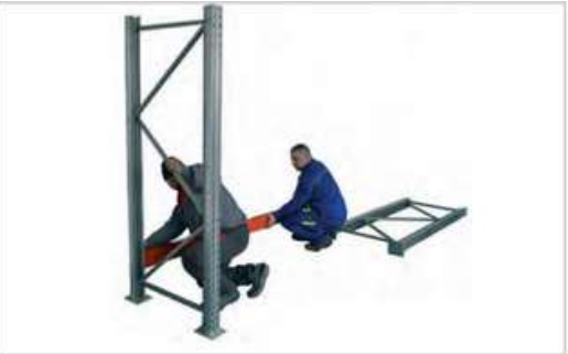
9 Paikoilleen asennettavilla vaakapalkeilla elementti tuetaan pystyyn.
