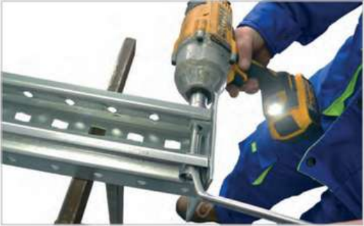
2 Vakioaluslevy kiinnitetään ruuvilla M10x70 lukkomutterilla M10.
