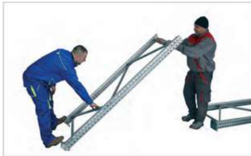
8 Elementtiä pystytettäessä pitää alapään luistaminen estää.
