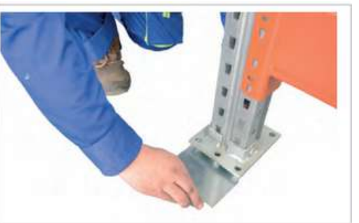
15 Suoruuden säätö tehdään täytealuslevyillä.
