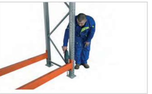
18 Hyllystön lattiaankinnitys: Pora lattiaan reiät kiinnitinmallin mukaan.
